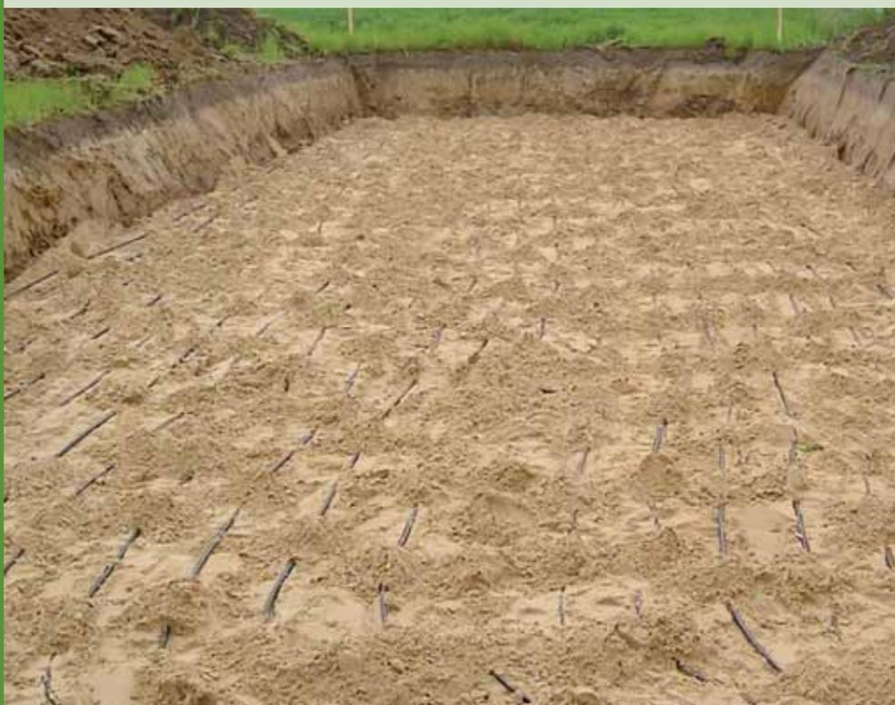
*Verlegung der Leitungen für Erdwärme-Flächenspeicher im Fundamentuntergrund.*
